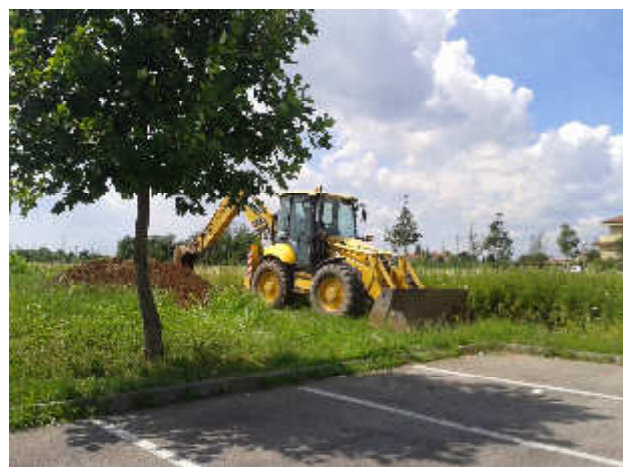
T2 - Escavazione trincea esplorativa e prova di permeabilità
