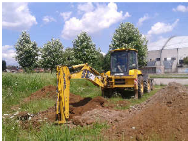
T1 - Escavazione trincea esplorativa e prova di permeabilità
